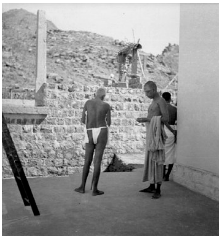
Dohled na stavbu budov
